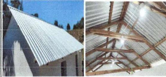
Foto 1: SUSTITUCION DE LAMINA TROQUELADA EN (MODULO 2)
